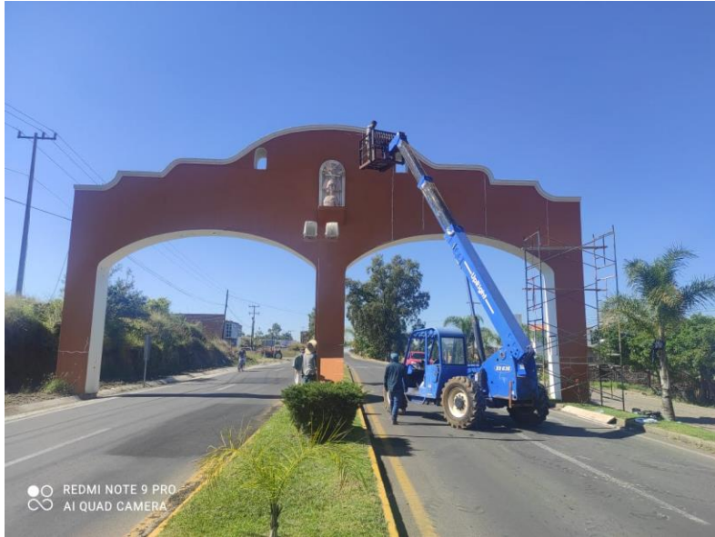
OBRA EN PROCESO
