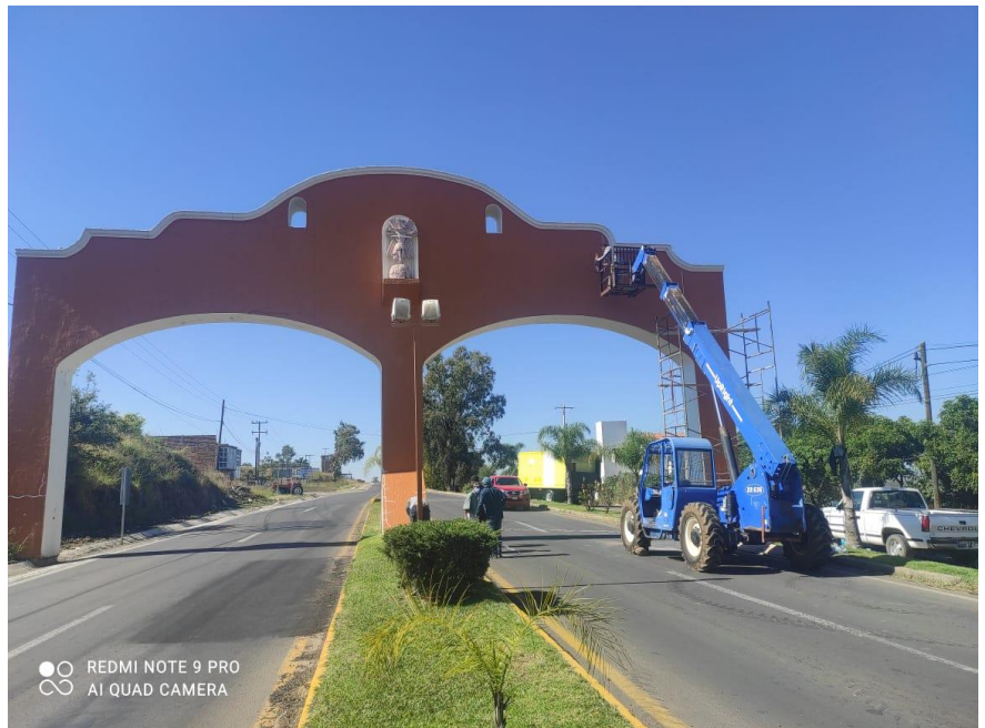
OBRA EN PROCESO
